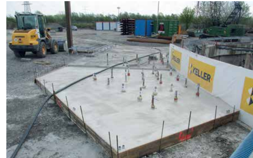
Vereisung Bodenkörper für Einfahrt Rohrvortrieb DN 1.600 in Zielschacht S_.042.a
