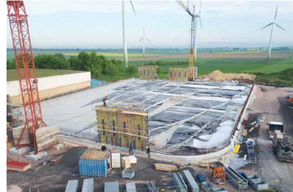
Bodenplatte in einem Guss betoniert
